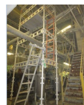
Jobbe i et stillas hvor stillaset er bygd rør utstyr som gjør tilkomsten/arbeidsstedet er trangt og ledende
