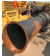
Jobbe inne i et rør
