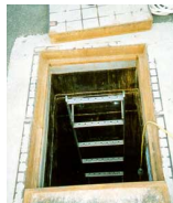
Arbeid i fuktige sjakter
